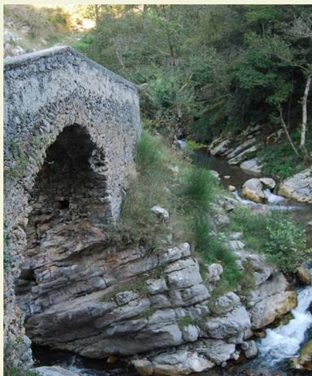
Un antico ponte con un arco che poggia sulla roccia, su un corso d'acqua nei pressi di Aieta.
