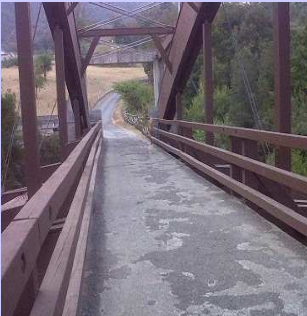
Brücke im Tal zwischen Laino und Papasidero (Kalabrien), wo der Fluss Lao fließt.
