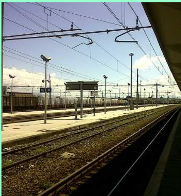
Immagine di binari di una stazione ferroviaria
