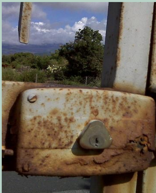
Bild eines verrosteten Schlosses an einem Tor.
