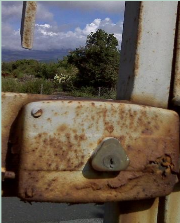
L'immagine mostra una serratura di un cancello corrosa dalla ruggine.
